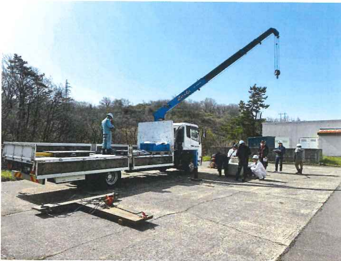
【実技講習：クレーン等の玉掛け】
