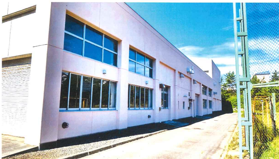
【人材開発センター北面外壁改修工事完成写真(610㎡) (R6.9.5撮影)
