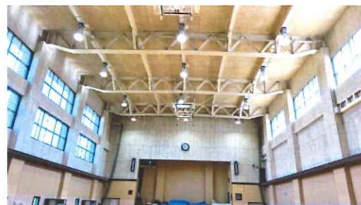
《体育館照明器具のLED化》
